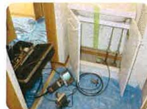
内視鏡検査、塗膜厚検査などでライニングの状況を確認し、
